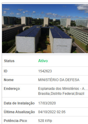
Figura 10 – Status de conexão ModBus com a plataforma SCADA desenvolvida.
